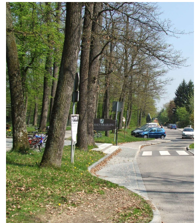
Abb 3: Rudolf-von-Hirsch-Straße, Gemeinde Krailling
