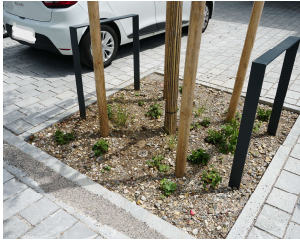
Abb 10: erweiterter Wurzelraum mit Versickerungsmöglichkeit unter dem Pflaster in der neuen Ortsmitte (© A. Akontz)
